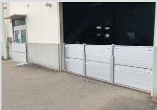
工場シャッター(屋内側設置) 人用扉(屋外側設置)
